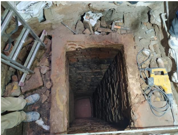
3. Vista del pou sense la coberta
