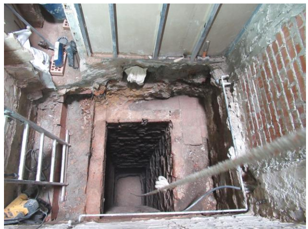
6. Vista general del pou
