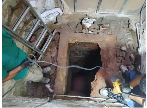
2. Desmuntatge de la coberta UE 03
