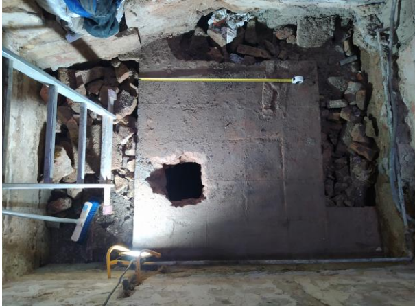
1. Coberta UE 03 un cop retirats el paviment inicia UE 01 i l'estrat UE 02
